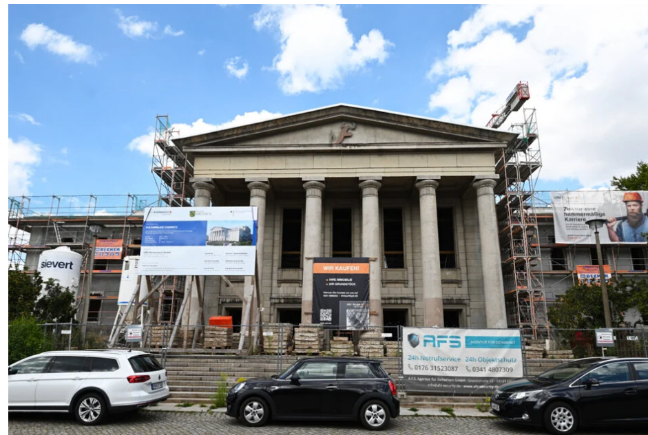
Der imposante Eingangsbereich inklusive Treppe bleibt erhalten. © Maik Börner
