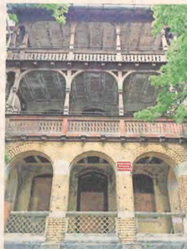
Mehr als 20 denkmalgeschützte Pavillons sollen rekonstruiert werden.
