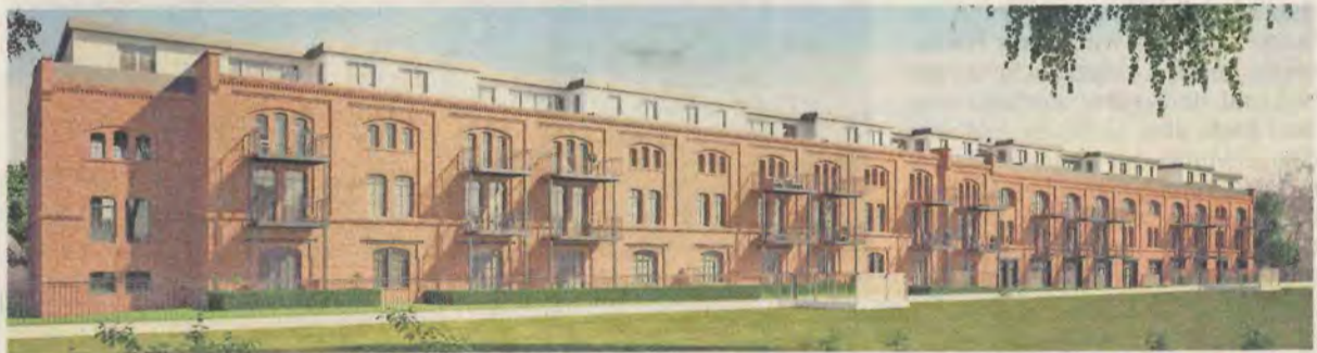
In der König-Albert-Residenz am südlichen Ende der Olbrichtstraße wird nun auch der Rote Riegel denkmalgerecht saniert. GRAFIK: K&P
