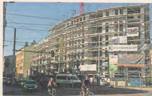
Auch direkt an der Westplatz-Kreuzung aus Friedrich-Ebert- und Käthe-Kollwitz-Straße entstehen neue Wohnungen.
