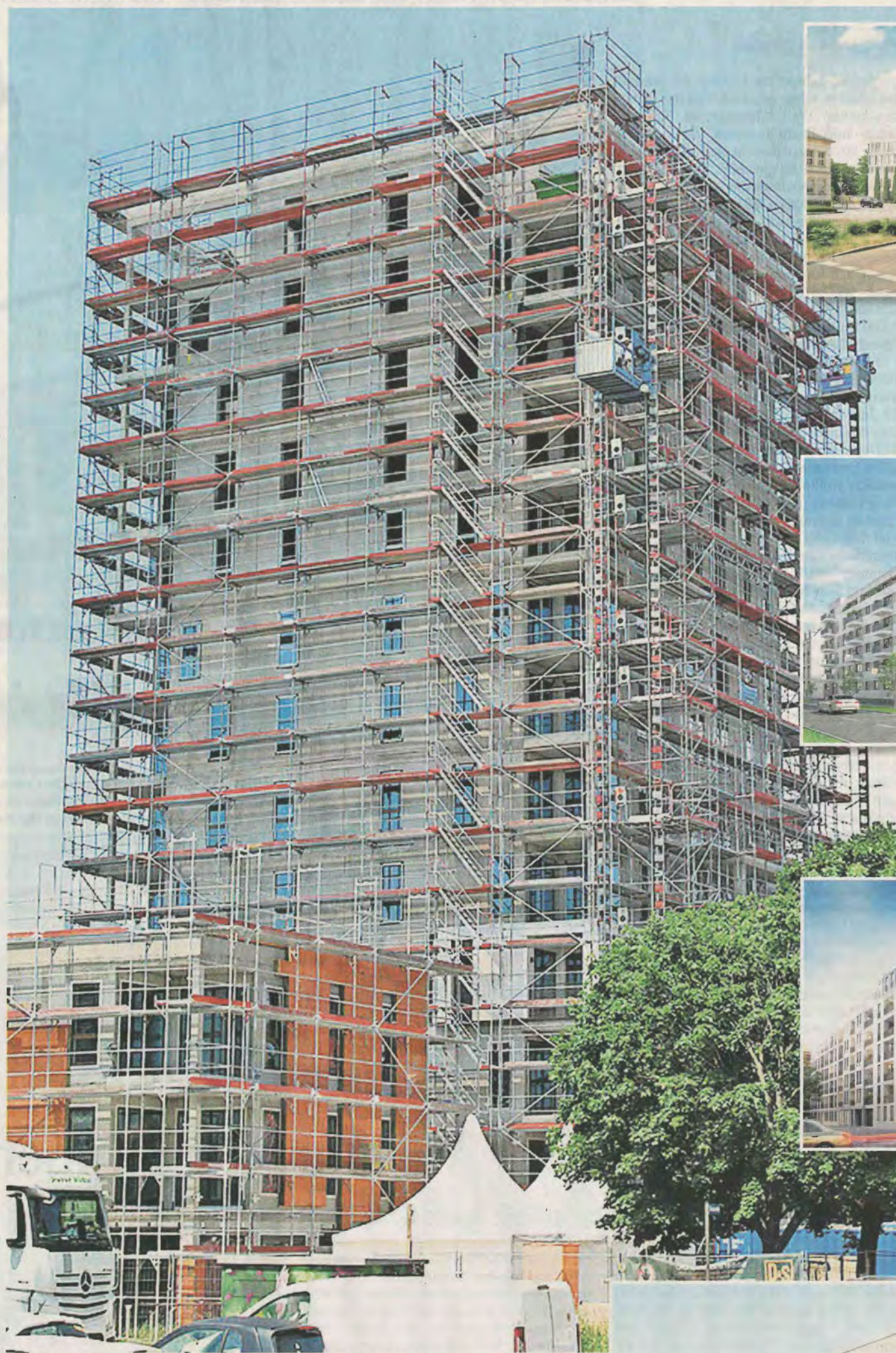
Der 42 Meter hohe Lipsia-Turm in Grünau steht nun im Rohbau.
