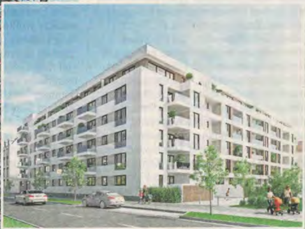
Für dieses Wohnhaus am Gerichtsweg wurde soeben der erste Spatenstich gesetzt. Foto: AOC Immobilien AG
