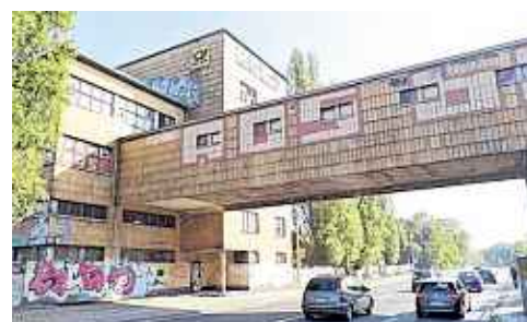
Der „Skywalk“ über der Adenauerallee ist mit Siegersdorfer Keramikplatten verkleidet.
