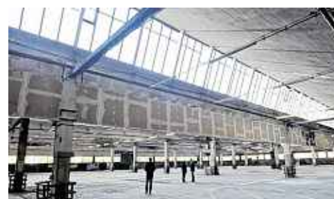
In der 115 Meter langen Sheddach-Halle haben einst auch häufig Studenten Pakete sortiert.
