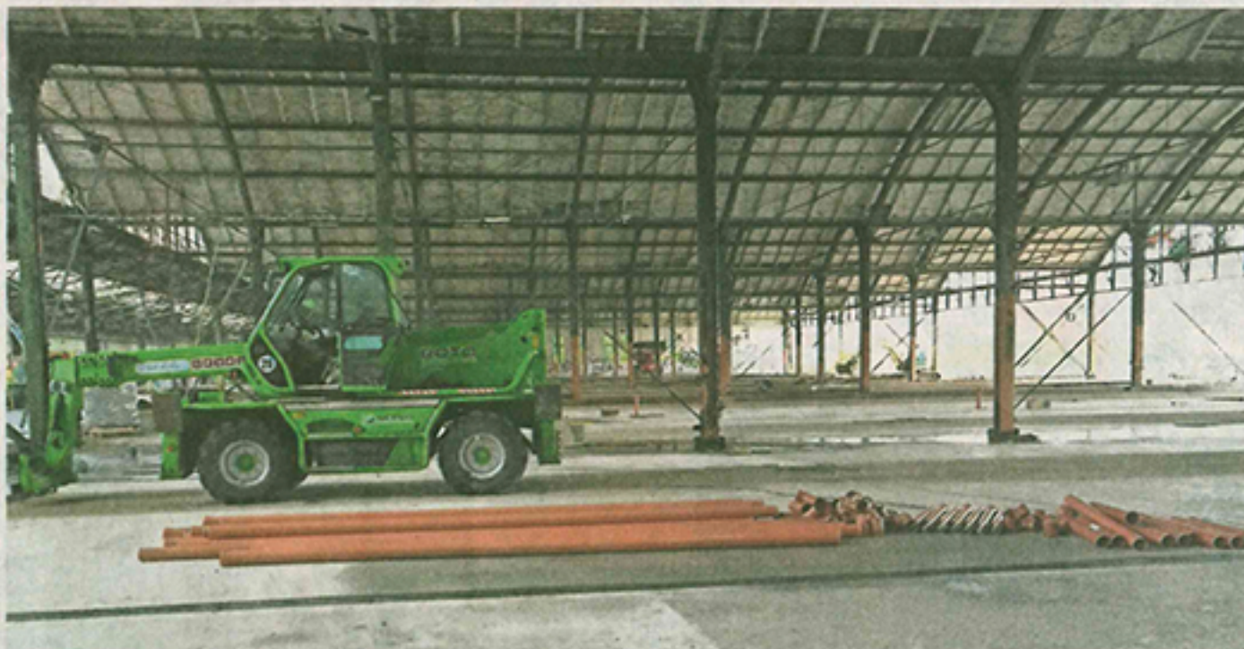
Zwei Drittel der Gleisstränge im früheren Postbahnhof sind bereits mit Betonelementen überwölbt worden, sodass eine ebene Fläche zum Aufstellen der farbenfroh gestalteten Wohnmodule (Foto unten) entsteht.
