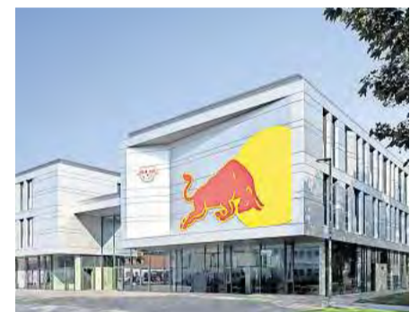
RB Leipzig nutzt dieses Trainingszentrum am Cottaweg 7. Entwurf: SHA Scheffler Helbich Architekten / Foto: Christian Eblenkamp
