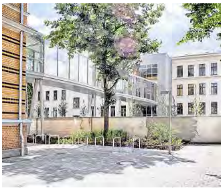
Das Goethe-Gymnasium in der Gorkistraße 25 erhielt eine gläserne Brücke. Entwurf: Wolterek Fitzner/Klipper/Pfau / Foto: Olaf Martens
