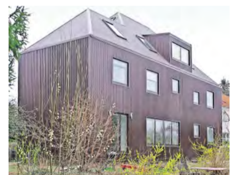
Ein KfW-Energieeffizienzhaus 70 entstand im Bechsteinweg 11 aus einem alten Wohngebäude. Entwurf und Foto: Bernhard Tatter
