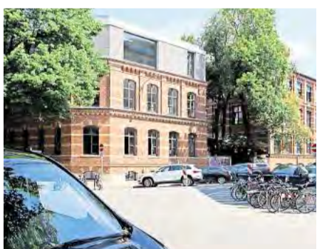
Das denkmalgeschützte Kontorhaus in der Holbeinstraße 29 bekam eine Wohntage aufs Dach. Entwurf und Foto: Knoche Architekten
