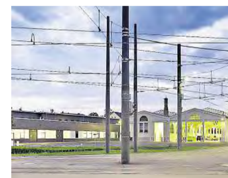
Der Straßenbahnbetriebshof Bornaische Straße 229 wurde komplett erneuert. Entwurf: Staupendahl & Partner / Foto: Michael Moser
