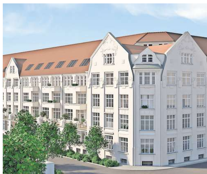
Im August soll das letzte Baugerüst an der „Großbuchbinderei Heinrich Sperlich“ in der Oststraße verschwunden sein. In dem Baudenkmal hat Instone 85 Wohnungen geschaffen. Im Hof entstand eine Tiefgarage mit Spielplatz oben drauf.
