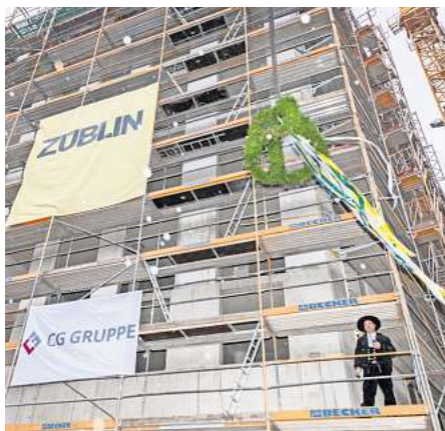
Für „Schumanns Gärten“ wurde gestern der Richtkranz aufgezogen. Foto: Tom Züfle
