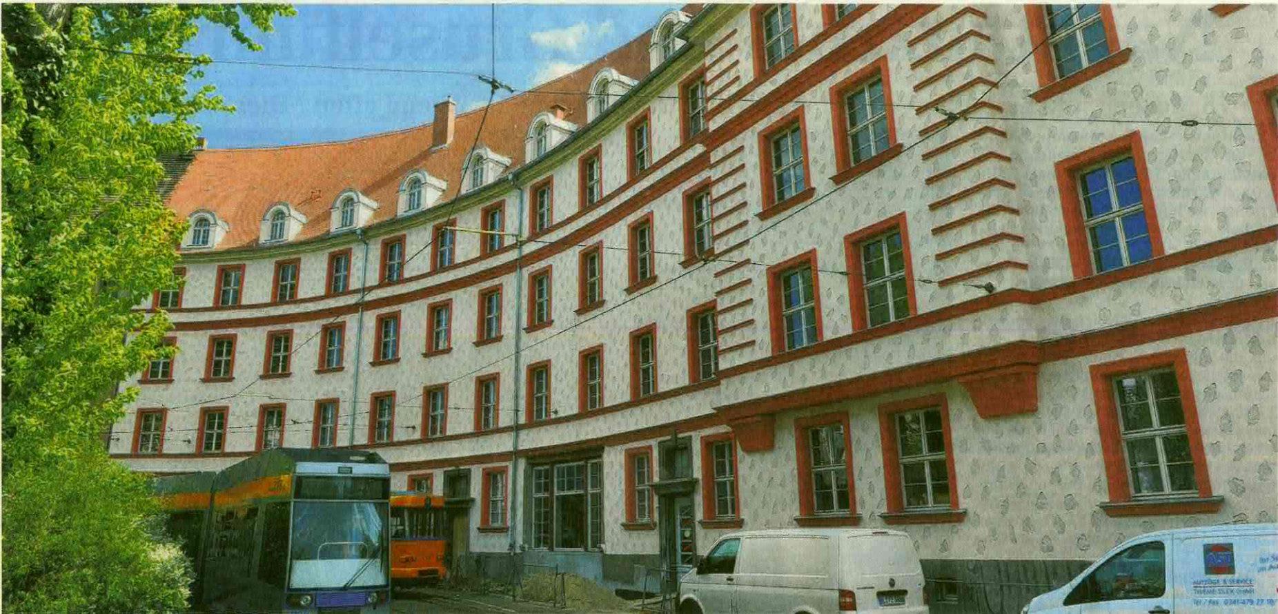
In den frisch sanierten Gebäuden am Pater-Aurelius-Platz sollen im Juli 54 Service-Wohnungen für Senioren eröffnet werden, die ein Pflegedienst betreut. Foto: Wolfgang Zeyen
