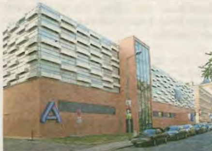
An der Nonnenstraße hat GRK gerade ein Parkhaus mit Aldi-Markt fertiggestellt.
