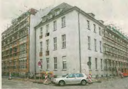
Beim Stötteritzer „Klangwerk“ ist der Rohbau für 209 Wohnungen fast geschafft.
