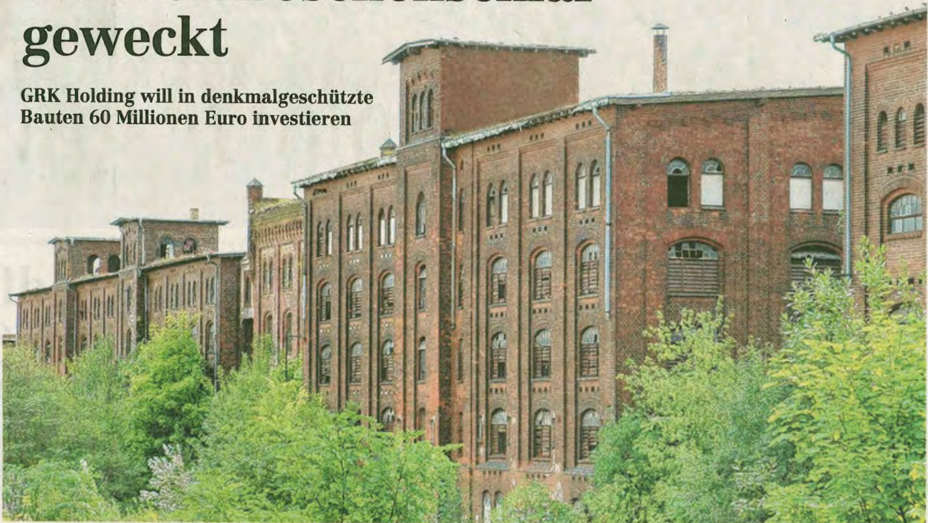
Die Gebäude der früheren Heeresbäckerei schlummern seit etwa 20 Jahren an der Olbrichtstraße, sollen nun bald saniert werden.
