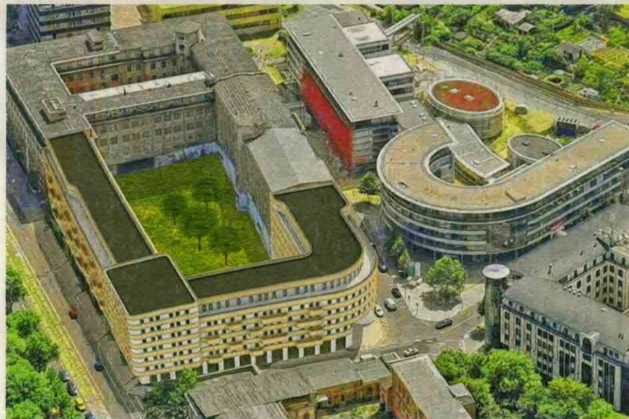
Ab nächstem Frühjahr soll das alte LKG-Gebäude (links oben) saniert und durch einen Anbau mit ockerfarbenen Naturstein-Fassaden ergänzt werden. Entwurf: Homuth & Partner
