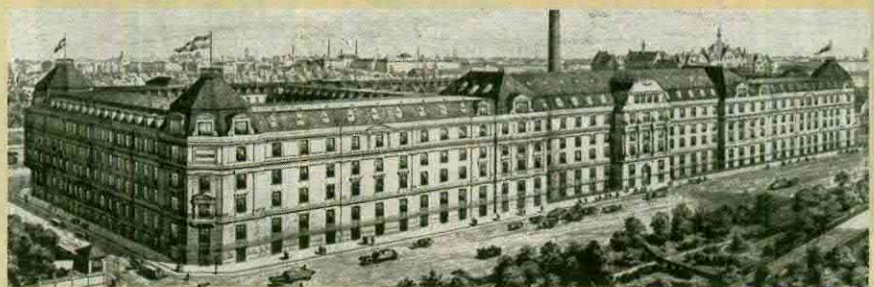
1907 wurde das 150 Meter lange Gebäude der Verlagsauslieferung Volckmar in der damaligen Königstraße (heute Prager Straße) eingeweiht. Foto: Koch, Neff & Volckmar
