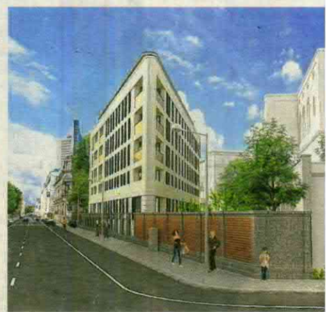
Einen spitzwinkligen Neubau mit Eigentumswohnungen errichten. Die Firma des Mäc-Geiz-Gründers Dirk Bolmerg an der Goldschmidtstraße 31 errichten. Entwurf: ...
