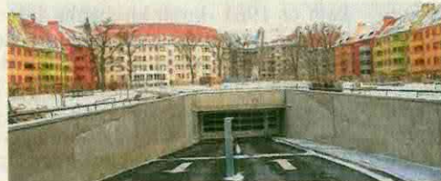
Auch die Sanierung des Wahrener Rundlings mit 200 Wohnungen schließt GRK dieses Jahr ab.
