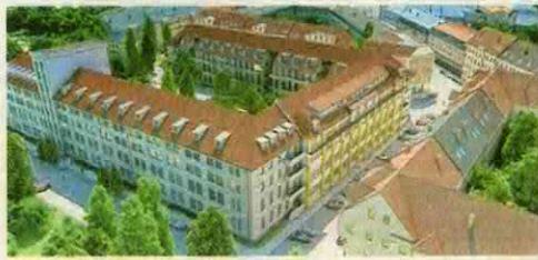
In der Melscher Straße startet GRK dieses Jahr den Umbau des RFT-Werks zu 200 Wohnungen.
