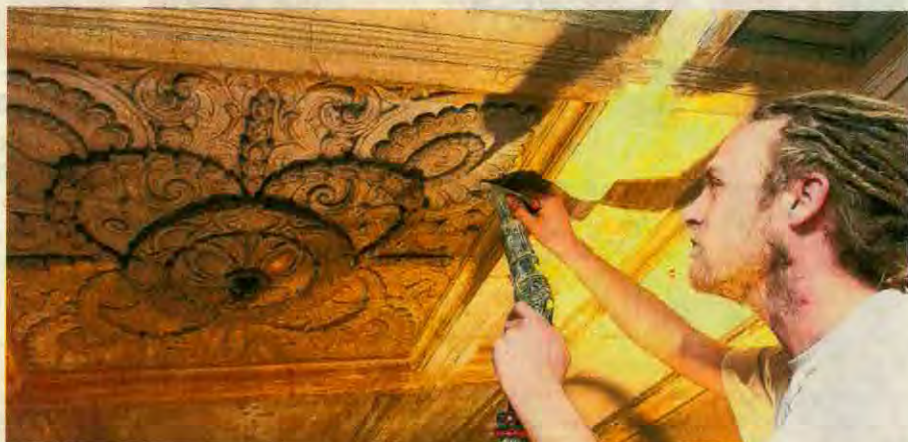
Stuckateur Thomas Bauch restauriert die Decke eines Durchgangs. Fotos: André Kempner
