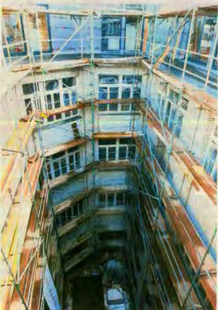
In diesem Lichthof werden zurzeit etliche weiß lasierte Klinkersteine ausgetauscht.
