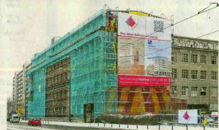
Das LKG-Gebäude an der Prager Straße ist ingerüstet. Drinnen laufen bereits bauvorbereitende Arbeiten. Foto: Wolfgang Zeyen
