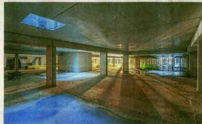
Eine Tiefgarage entsteht neben dem Interdruck-Haus in der Salomonstraße. Ab Juni sollen hier 112 Autos parken. Foto: CG-Gruppe
