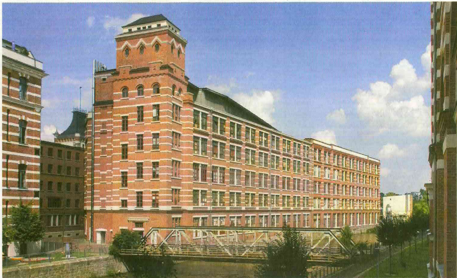
Die Buntgarnwerke sind Europas größtes Industriedenkmal aus der Gründerzeit. Bis Mitte 2013 soll der gesamte Komplex saniert sein. Bilder: GRK Holding
