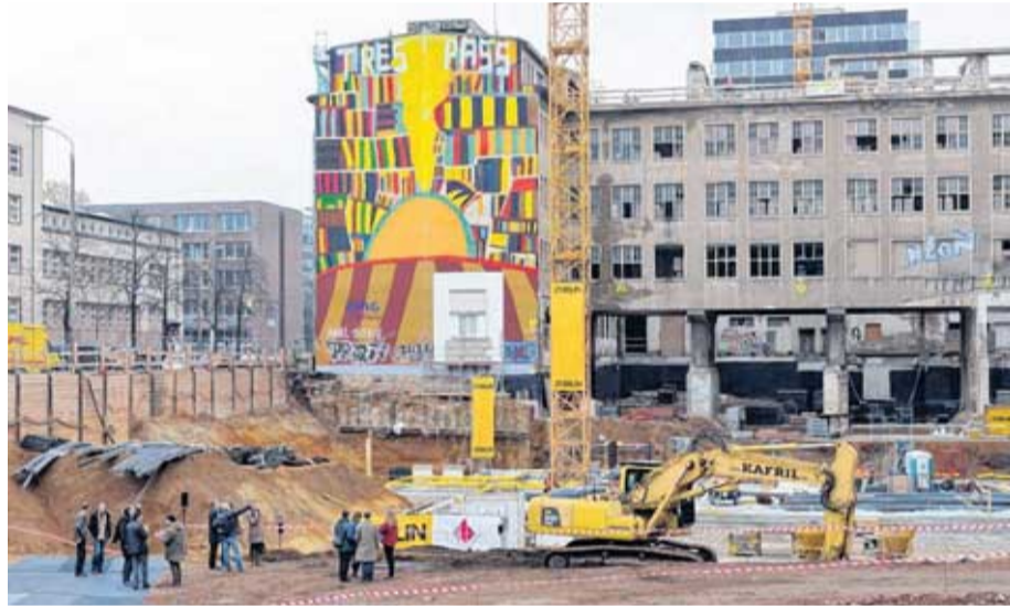
Im kriegszerstörten Teil des LKG-Ensembles errichtet die Firma Züblin im Auftrag der CG-Gruppe einen Neubau mit zweistöckiger Tiefgarage. Fotos: Wolfgang Zeyen
